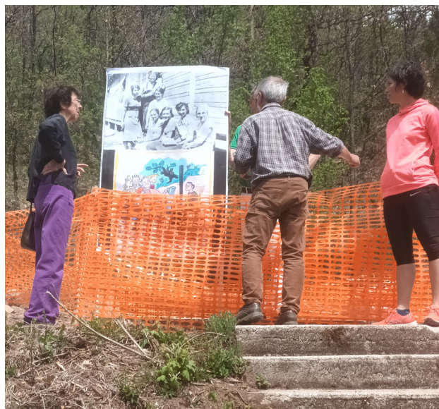
Michèle Descolanges, Patrick Lescure et Anaïs Montes sur le chantier. DR
